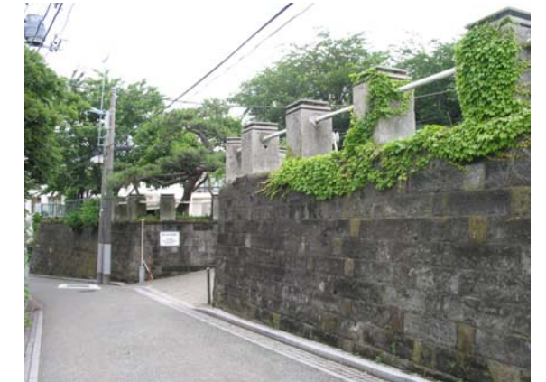
横浜地方気象台前のブラフ積み擁壁
