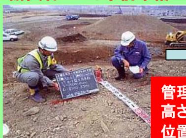
管理断面上での長さ、高さの計測
