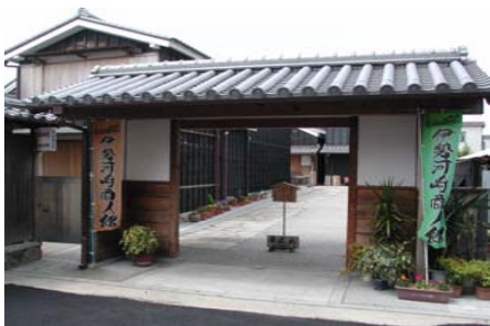
伊勢河崎商人館外観。内部は資料館、飲食・物販施設。
