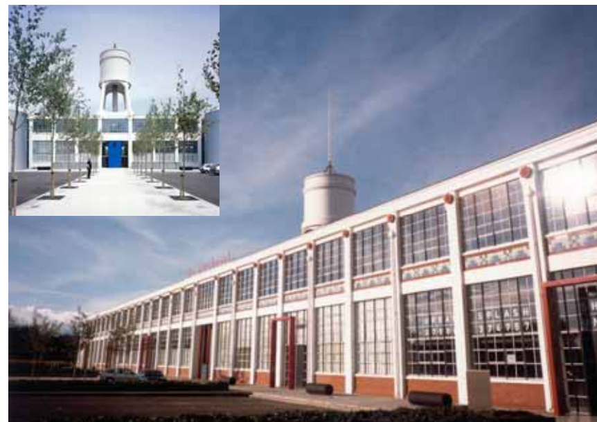
一期事業実施後(2002年)
