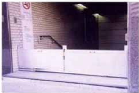
▲仙台市営地下鉄 五橋駅
