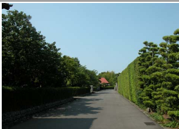
電柱が移設された通りには、商業看板、自動販売機等もなく、情緒ある景観が蘇った。
