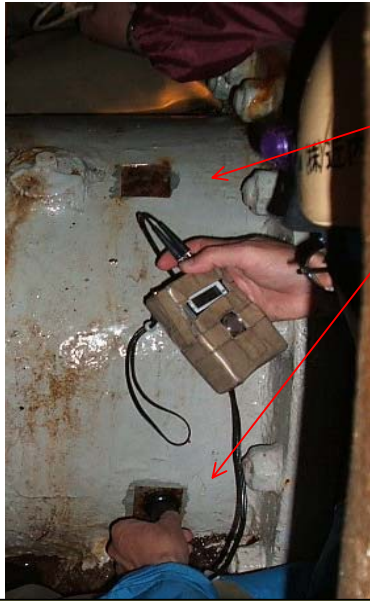
放流管の鉄管厚測定状況
