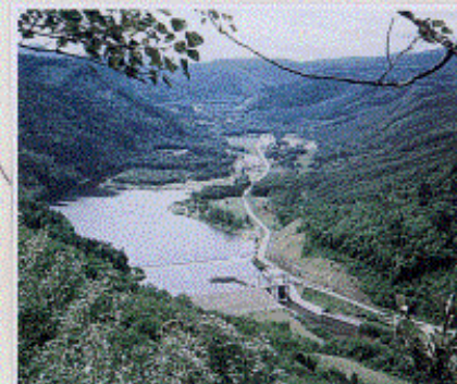
ムリ セツセ 武利ダム（瀬戸瀬発電所）
