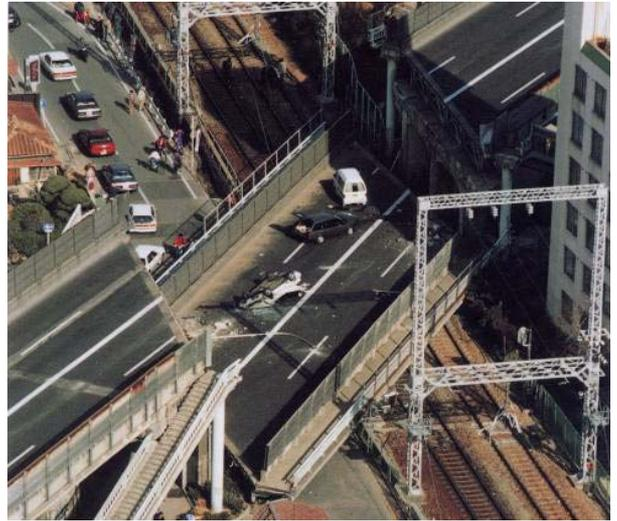
写真・兵庫県南部地震における跨線橋（在来線）の被災状況
