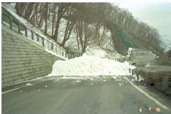
【S59.4.10 火打における雪庇処理】
