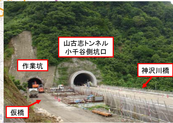
② 工期短縮を図りつつ、冬期間も休まず進めてきたトンネル工事(※) (平成18年7月25日撮影) ※仮橋と作業坑の施工により、トンネル・橋梁を同時に施工できることとし、工期を大幅に短縮
