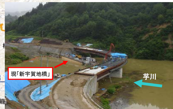
① 開通に向け急ピッチで進む新宇賀地橋の架替え工事 (平成18年7月25日撮影)
