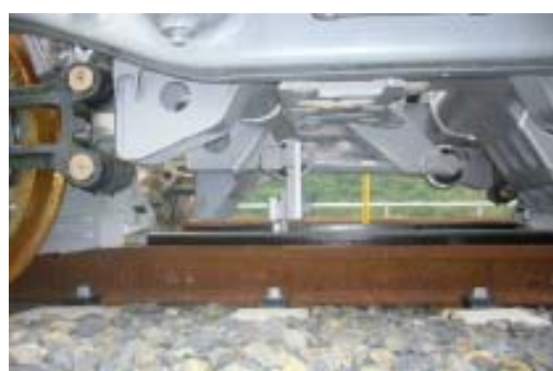
台車設置状況
