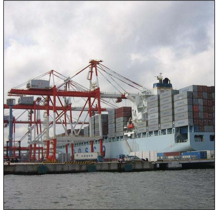
ガントリークレーン
