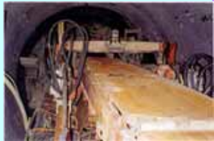
現場(シールド工事)
