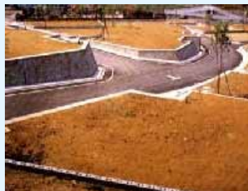
盛土、土地造成
