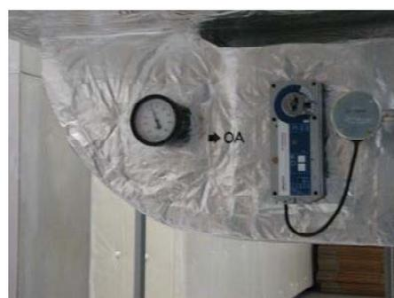
図3-1-29 外気取入用ダンパーの調整
