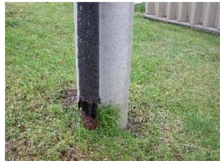
図3-1-18 電気配管の経年劣化
