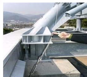
図3-1-10 鉄塔架台のターンバックルのゆるみ
