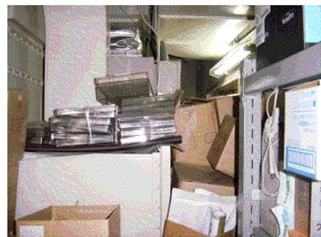
図3-1-16 設備室内に可燃物の設置
