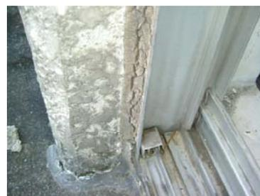
図3-1-21 建具シール材の劣化
