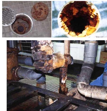
図3-1-12 給排水設備の劣化
