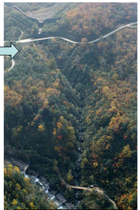
昭和39年の災害復旧を経て 緑が復元した泥谷 堰堤20基 床固3基 登録有形文化財 平成14年6月
