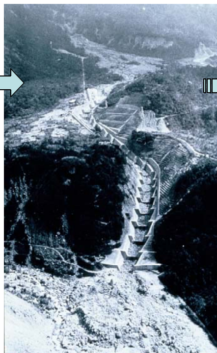
完成した泥谷砂防堰堤群(昭和13年)
