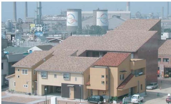
▲ 街づくり協定により屋根材を同一の瓦製品とし、3.5寸勾配北下りの片流れ屋根で統一されている。
