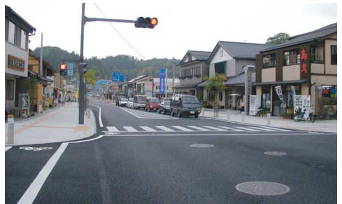
▲ 磐州通りの南側に平行して在る表通りは、三春町景観条例により景観誘導し魅力ある個店が連なる商店街となっている。 歩道の御影石仕上げや電線地中化等の景観整備がされている。
