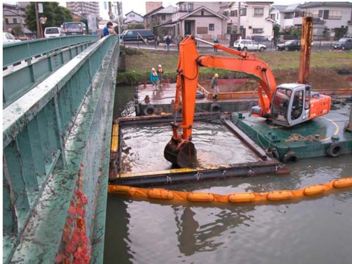
図 6.2.4 覆砂施工状況
