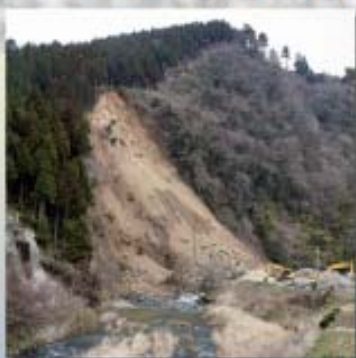
輪島市熊野で発生した河道閉塞
