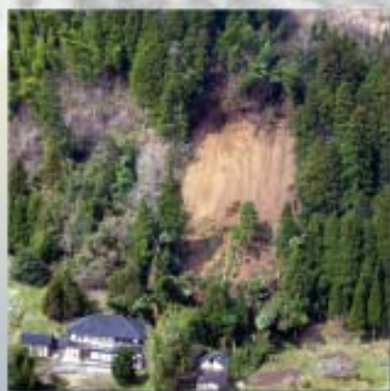
輪島市門前町小山で発生したがけ崩れ
