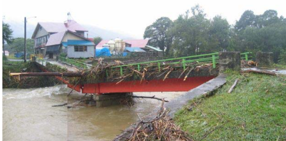
③町道小坂桐沢線 桐沢橋(西和賀町沢内川舟地内)
