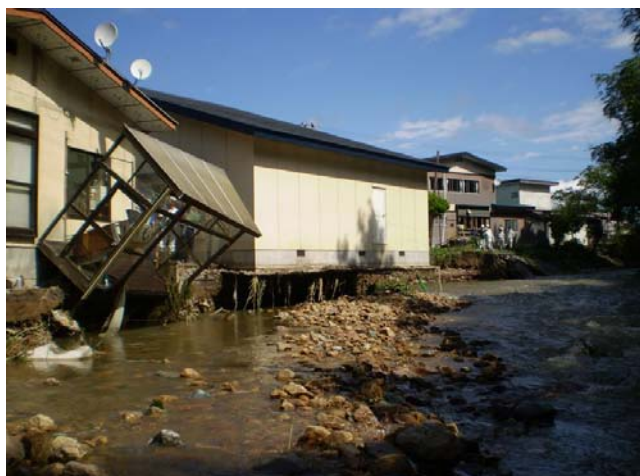
①一級河川 矢神川(八幡平市田山地内)
