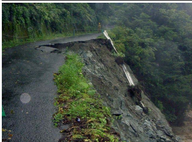
④町道 丸子峠線(西和賀町本屋敷地内)
