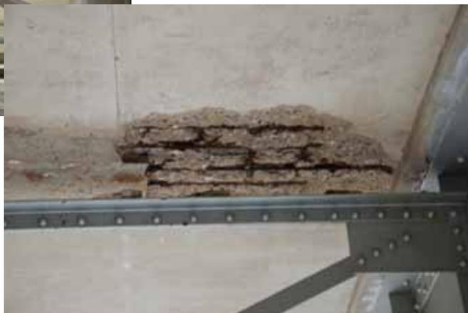
床版下面の剥離・鉄筋露出
