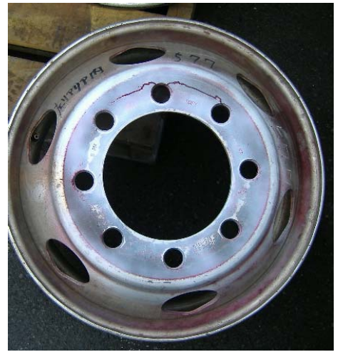
A：円周状の亀裂（亀裂のみ）
