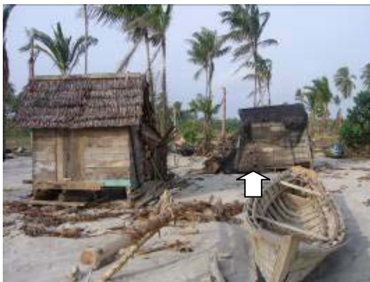
写真－4 押し流された小屋
