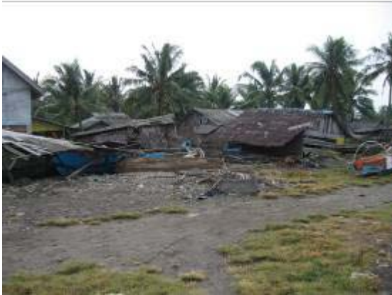
写真－6 破壊した小屋
