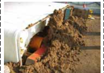
写真-2 アプローチ掘進
