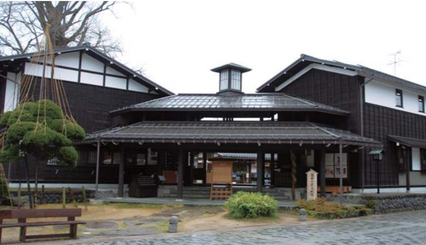
「飛驒の匠文化館」。建物は飛驒で育った木材を使い、飛驒の匠の技を受け継ぐ地元の大工さん達によって建てられ、組手や継手を用いているのが特徴。館内には大工道具の展示や木組みなどの体験コーナーがある。
