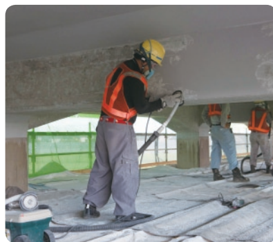
足場が組まれた高架橋下。中性化抑止のための表面保護工の工事中。
