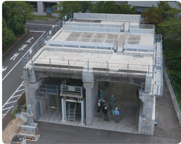
さまざまな劣化・損傷が生じ撤去された橋梁の部材を全国から集めて造られたニュー・ブリッジの全景。
