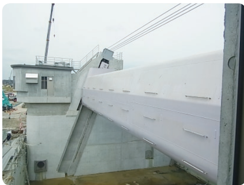
旧ゲート（ローリングゲート）の溝を利用して、剛性が高いシェル構造ローラゲートへ更新。
