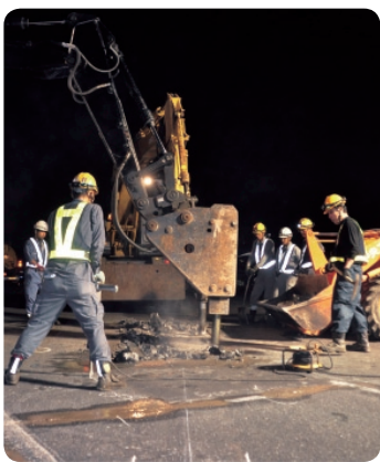
舗装工事の様子
