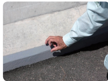
防水層は通常、舗装の段階で隠れてしまうが、さらに高く塗布することで（手で差している部分）、床版のコンクリートを雨水から守ることが期待されている。
