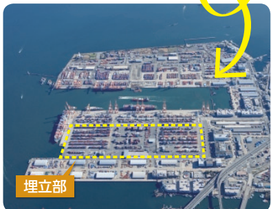
（写真上）工事前の本牧ふ頭 （写真下）工事後の本牧ふ頭 老朽化したくし形部分の埠頭を埋め立てヤードを広くしながら、大型船が接岸可能となる対応を図った。
