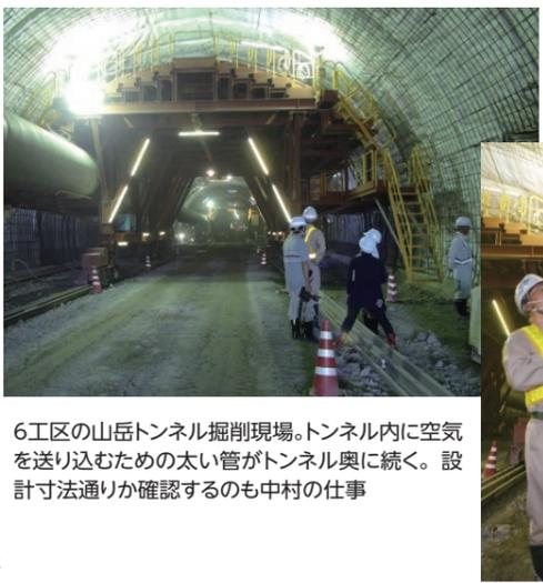
6工区の山岳トンネル掘削現場。トンネル内に空気を送り込むための太い管がトンネル奥に続く。設計寸法通りか確認するの中村の仕事
