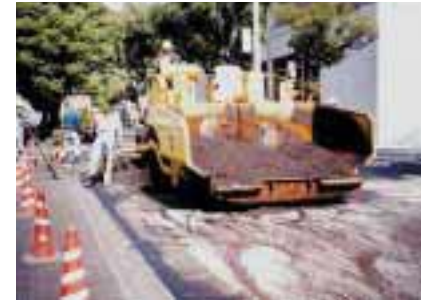
焼却灰入りアスファルトの舗設作業
