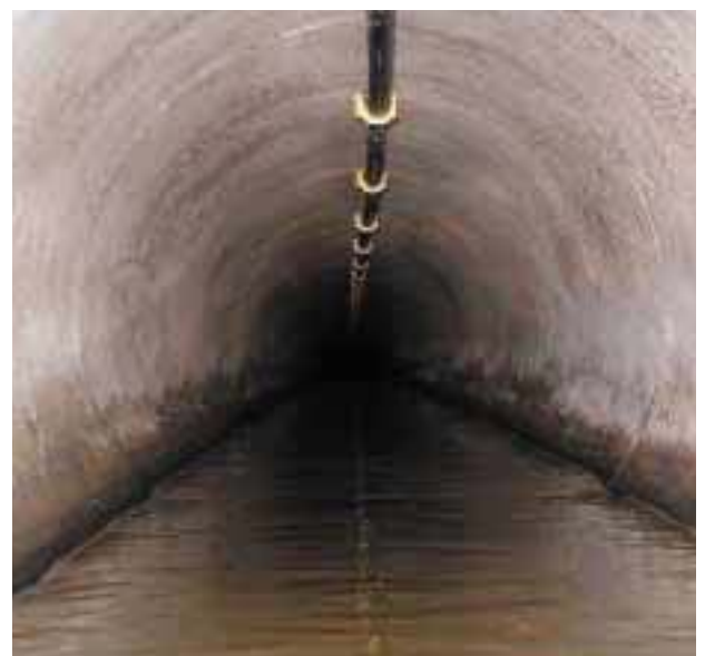
光ファイバー敷設状況(東京都)
