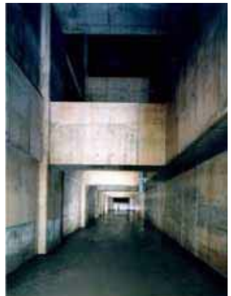
福江雨水滞水池 施設内写真(最大水深13mになります)
