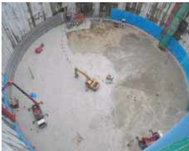
新千田ポンプ場 施工状況写真（深さ約40mあります）
