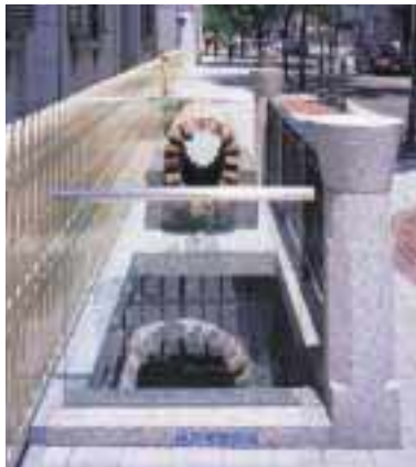
旧居留地内煉瓦造下水道
