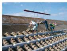
発生ブロック(撤去材)+新材により多自然護岸として再利用
