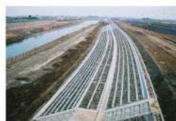
発生ブロック(撤去材)+新材により多自然護岸として再利用
