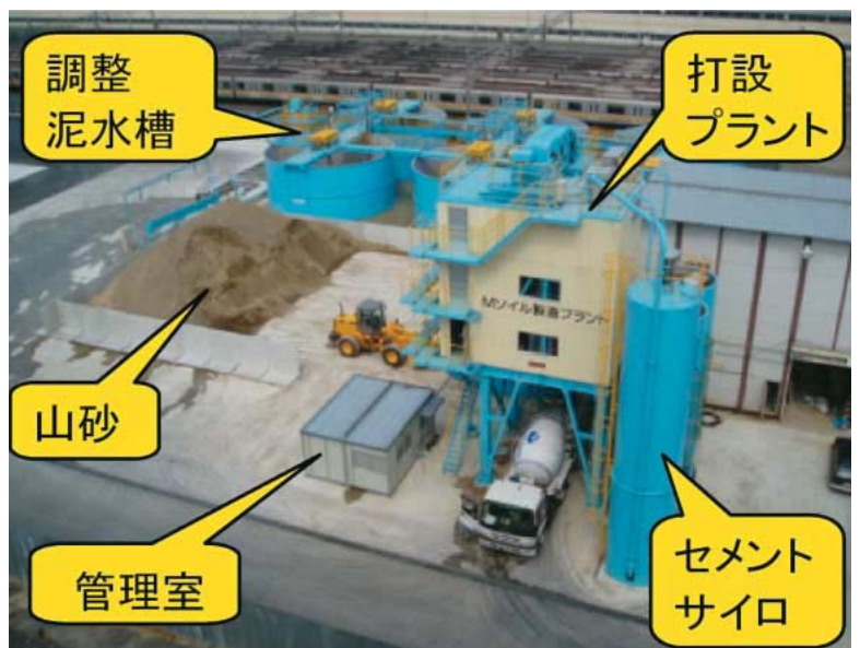
写真2 新木場リサイクルプラント全景
