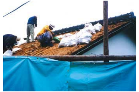
写真4 屋根葺土の再利用
