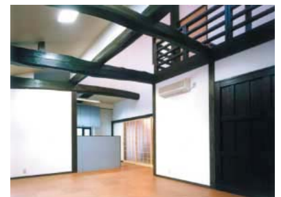
写真1 再生された居間の梁と腰壁
