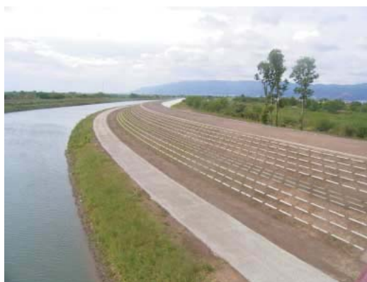
施工直後の様子
