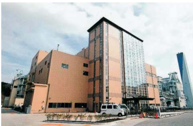
エコセメントの適用事例(製造工場管理棟)
