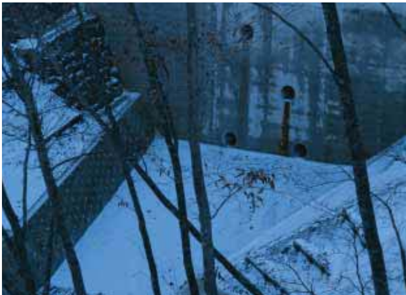
初めての冬を待つ砂防えん堤
