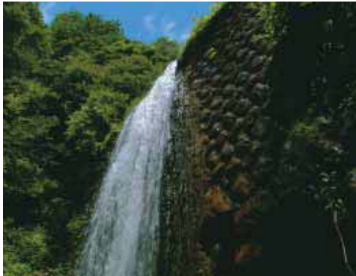
昭和初期に作られた石積みのおん堤
