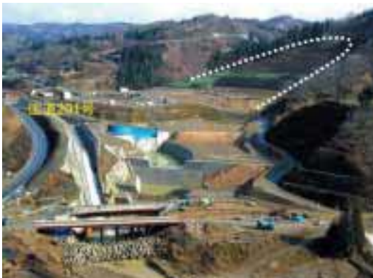
復旧状況：平成18年12月撮影
