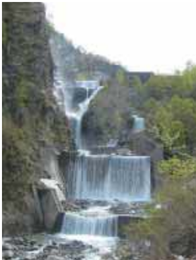
白岩砂防えん堤
