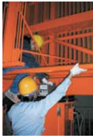
レーダーアンテナ点検
