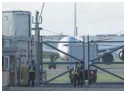
不法侵入対策フェンス
