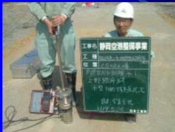
小型FWD試験状況
