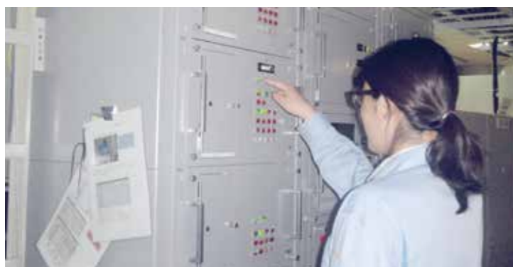
点検・保守作業 システムを万全な状態に維持
