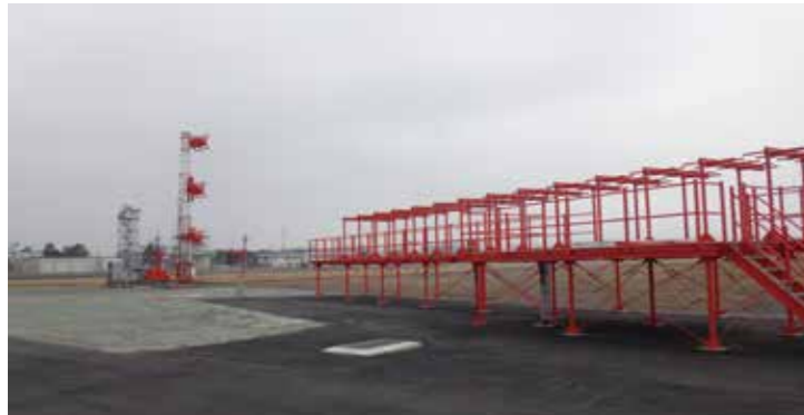
計器着陸装置 滑走路へ進入する航空機を電波で誘導
