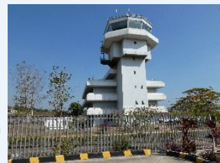
約20年前、日本の支援で立てられた 管制塔（ポートモレスビー国際空港）
