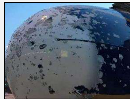
機首への降ひょうの被害状況 (*)2
