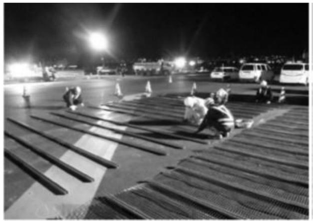
写真 - 5 溝形鋼・ジオグリッド設置状況
