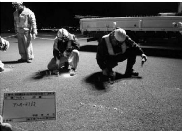
写真 - 4 アンカー打設状況
