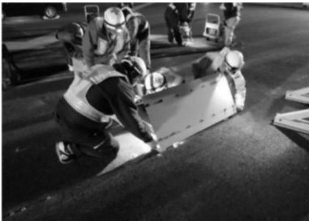
写真 - 3 仮設ブラストフェンス設置状況
