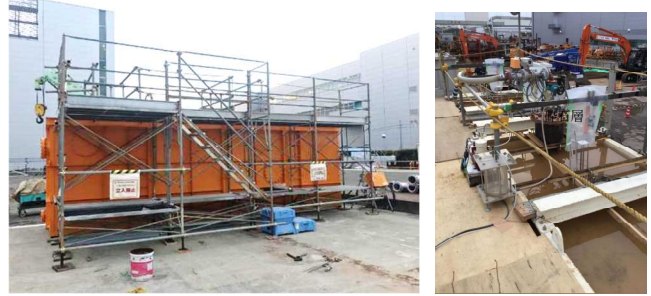
写真-1 土槽外観(左)と土槽上部(右)
