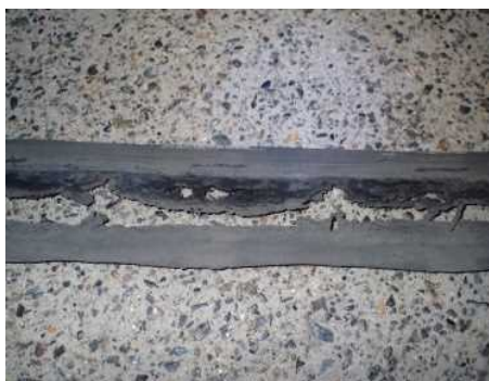
ベースゴム劣化②
