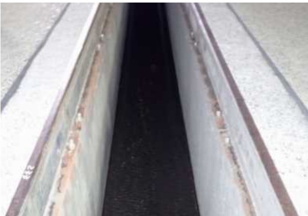
グレーティング取り外し時
