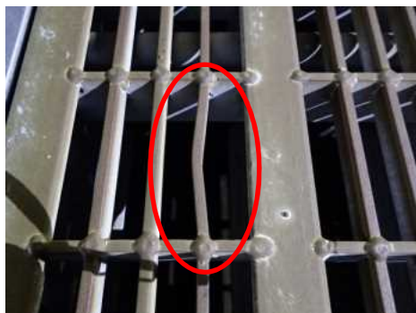
補助部材変形
