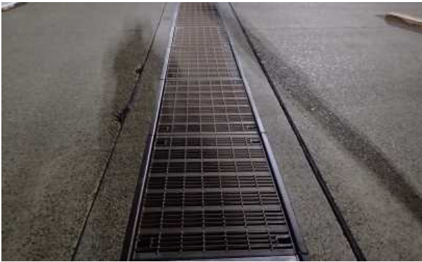
既設グレーティング設置時①
