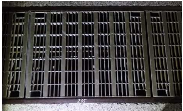
グレーティング設置時②
