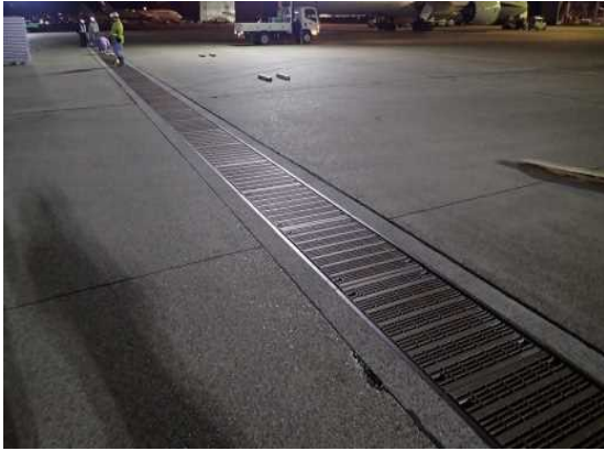
グレーティング敷設状況①
