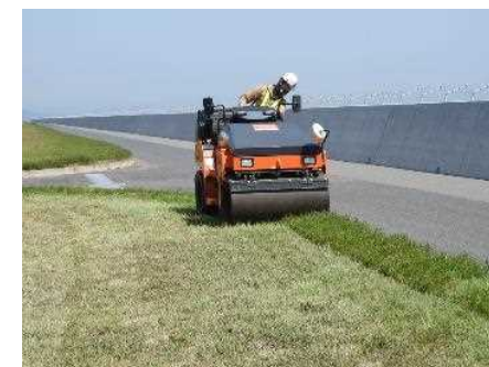
ローラー転圧風景
