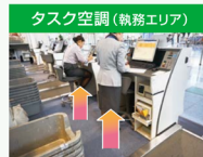
上部からは大空間用の空調吹出しを設置し、アンビエント空調を行うことで省エネ空調を実現します。
