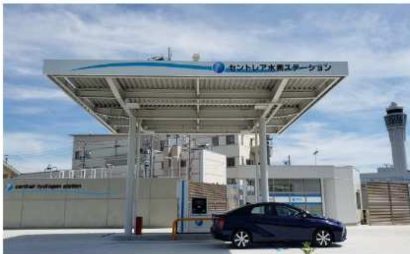
セントレア水素ステーション（商用）
