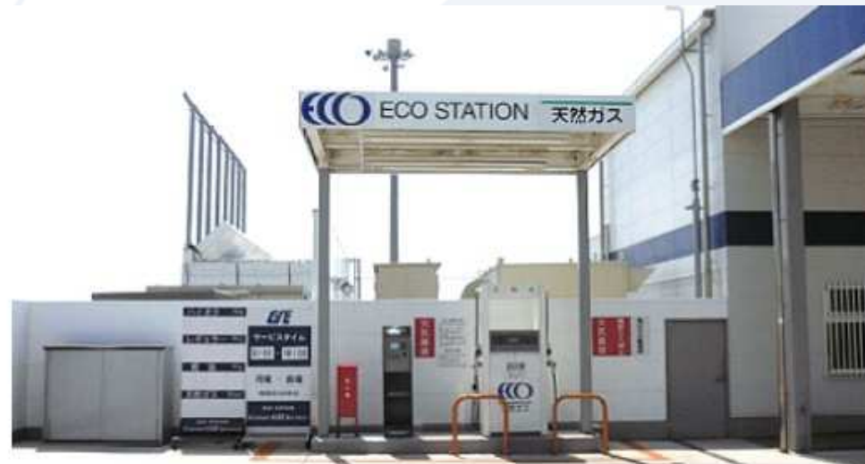
天然ガスステーション
