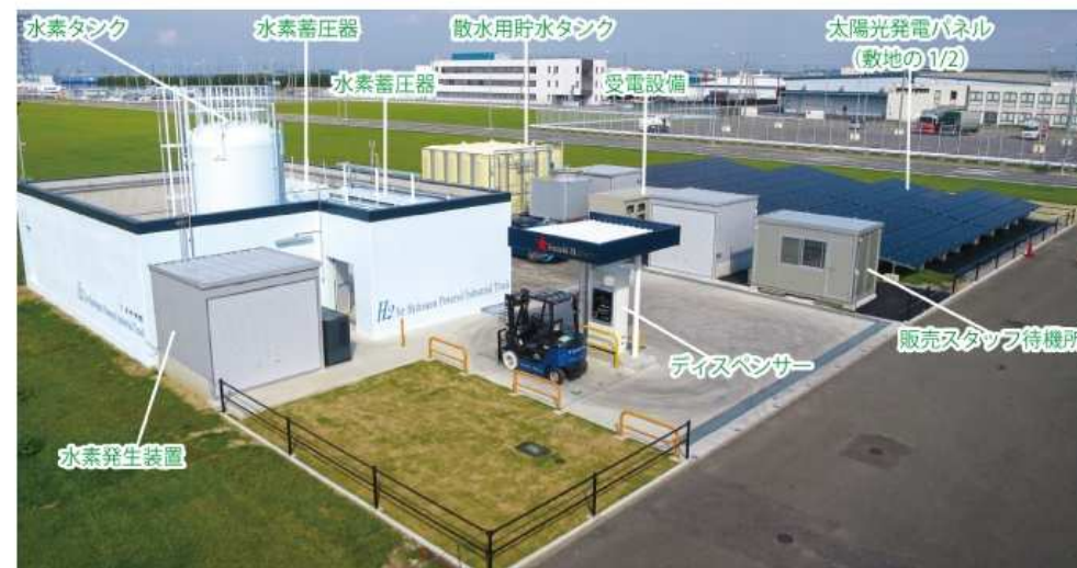
貨物地区水素ステーション（産業用）
