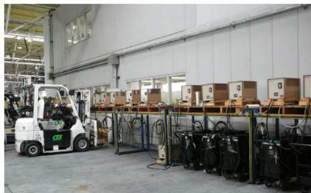
充電中の電動フォークリフト
