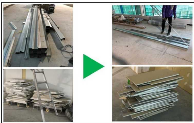
図：施工後の現場廃材量の比較 左：従来施工階、右：プレカット施工階
