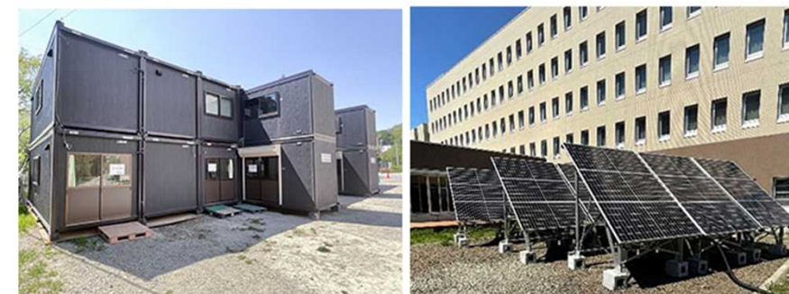
図：仮設現場事務所・太陽光発電パネル
