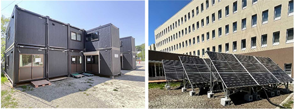
図 4.2.3 仮設現場事務所・太陽光発電パネル
