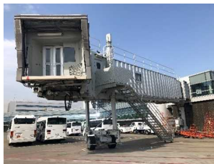
図 3.2.14 放射冷却素材を用いたフィルムを施工された PBB
