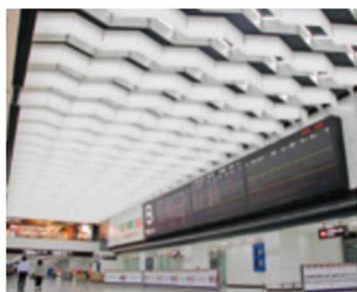
第2旅客ターミナルビル 国際線到着ロビー
