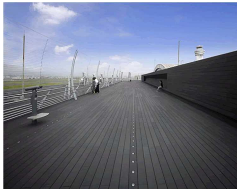
図 4.1.5 木材・プラスチック再生複合材(WPRC)のデッキでの施工例
