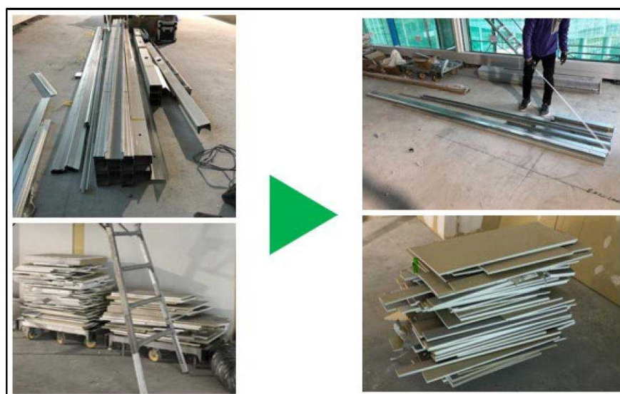
図 4.2.1 施工後の現場廃材量の比較_左:従来施工階、右:プレカット施工階 (上段:軽量鉄骨(LGS)乾式壁下地材、下段:石膏ボード)
