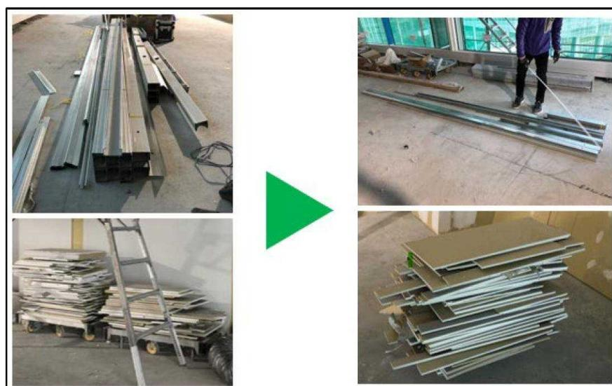
図 4.2.1 施工後の現場廃材量の比較\_左:従来施工階、右:プレカット施工階
