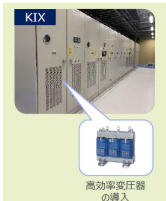
図 5.9 高効率変圧器
