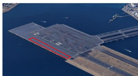
羽田空港D滑走路着陸帯 8 (舗装部)
