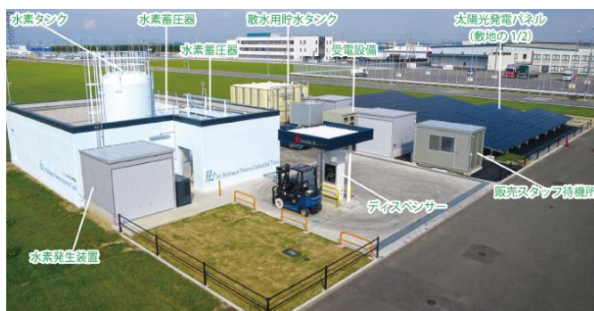
図 3-10 太陽光発電を用いたオンサイト方式水素ステーション例（中部国際空港）
