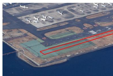
羽田空港C滑走路着陸帯 8 (舗装部)
