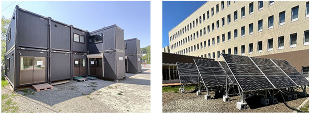
図 2-6 仮設現場事務所・太陽電池パネル
