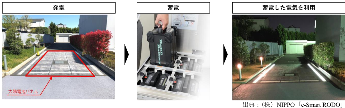
図 4-20 路面型太陽電池の活用モデル
