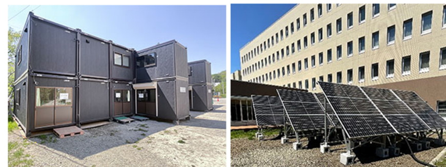
図：仮設現場事務所・太陽電池パネル
