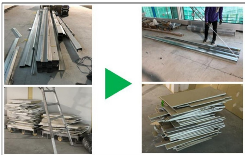
図：施工後の現場廃材量の比較 左：従来施工階、右：プレカット施工階
