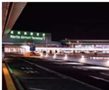
第1旅客ターミナルビル 出発カープサイドLEDサイン
