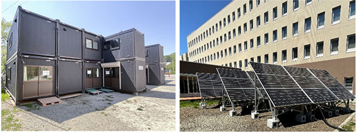
図 4.2.3 仮設現場事務所・太陽電池パネル 出典：五洋建設株式会社 HP
