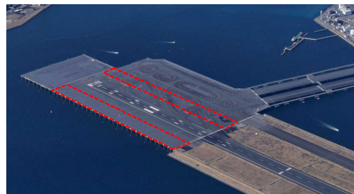
東京国際空港 D滑走路着陸帯の舗装部
