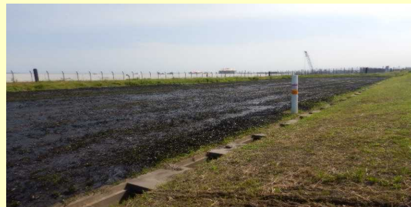
施工後(アスファルト乳剤散布)
