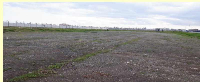
施工後(アスファルト乳剤散布)
