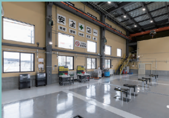
作業現場にも冷暖房完備
